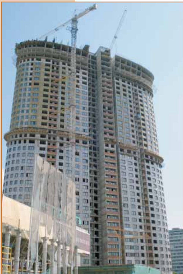
40-этажное высотное здание в Москве на ул. Профсоюзная, на крыше которого планируется размещение позиции ДМРЛ-С (июль 2011 г.).
