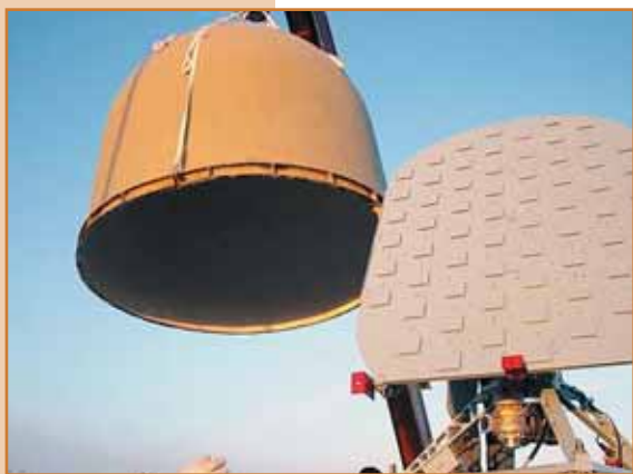
Установка радиопрозрачного укрытия МАРЛ-А. Фото Северного УГМС.
