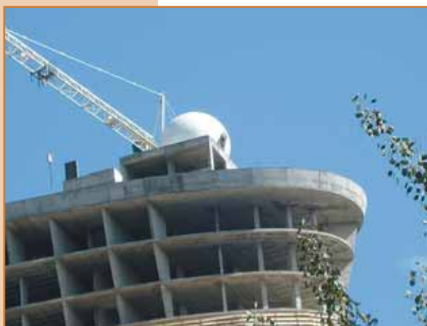
Работы по монтажу оборудования ДМРЛ-С на крыше 40-этажного высотного здания в Москве на ул.Профсоюзная 16-17 августа 2011 г.
